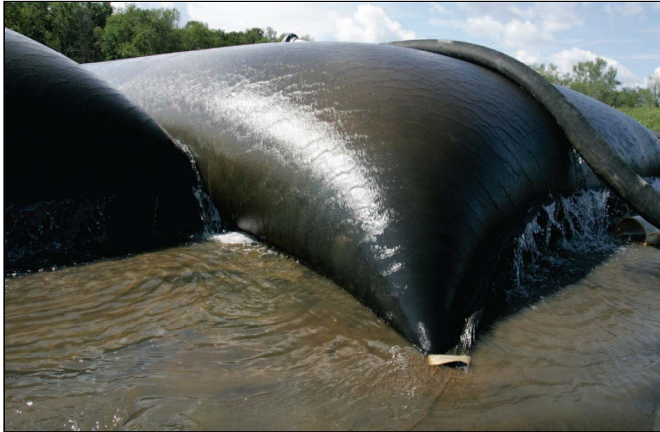
Photo 2.8 Géotubes en phase remplissage
