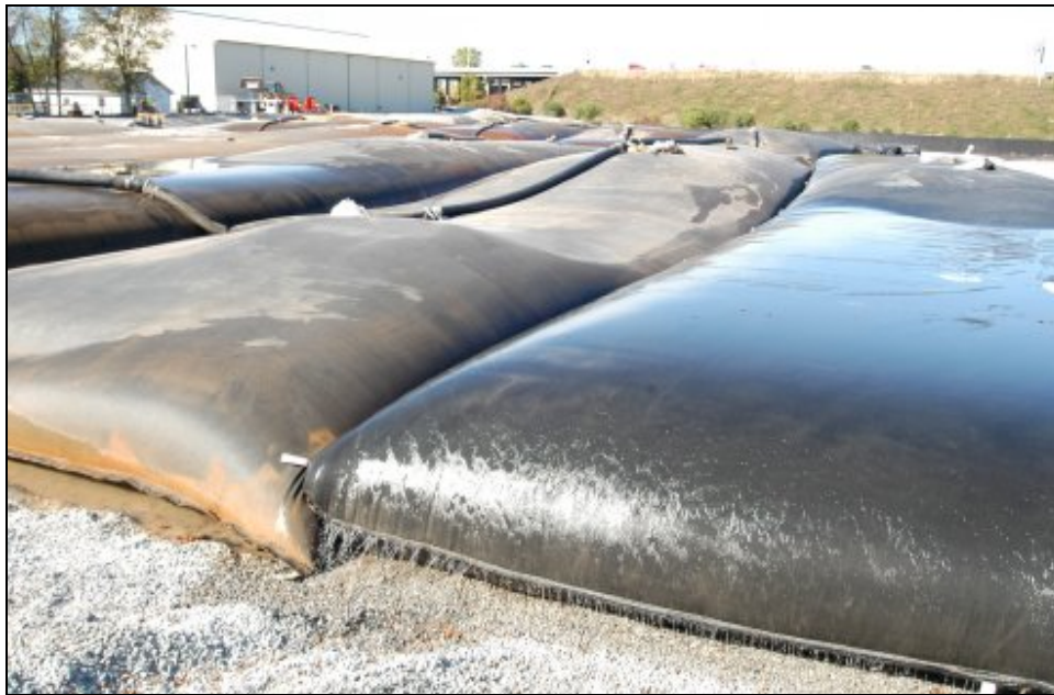
Photo 2.7 Géotubes en phase remplissage
