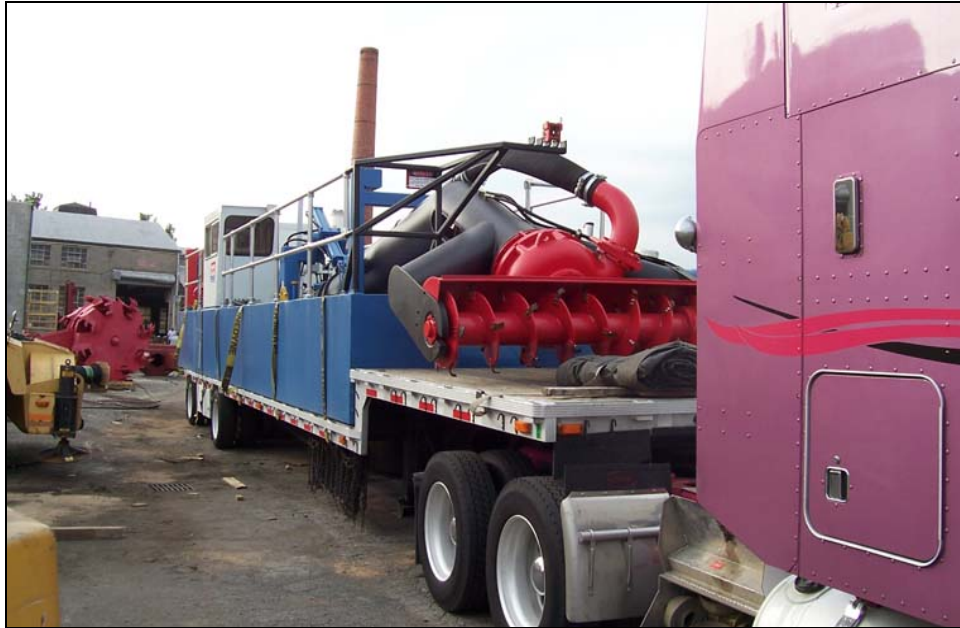
Photo 2.6 Transport sur route de la drague à tarière horizontale
