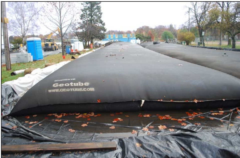
Photo 2.9 Géotubes en phase déshydratation
